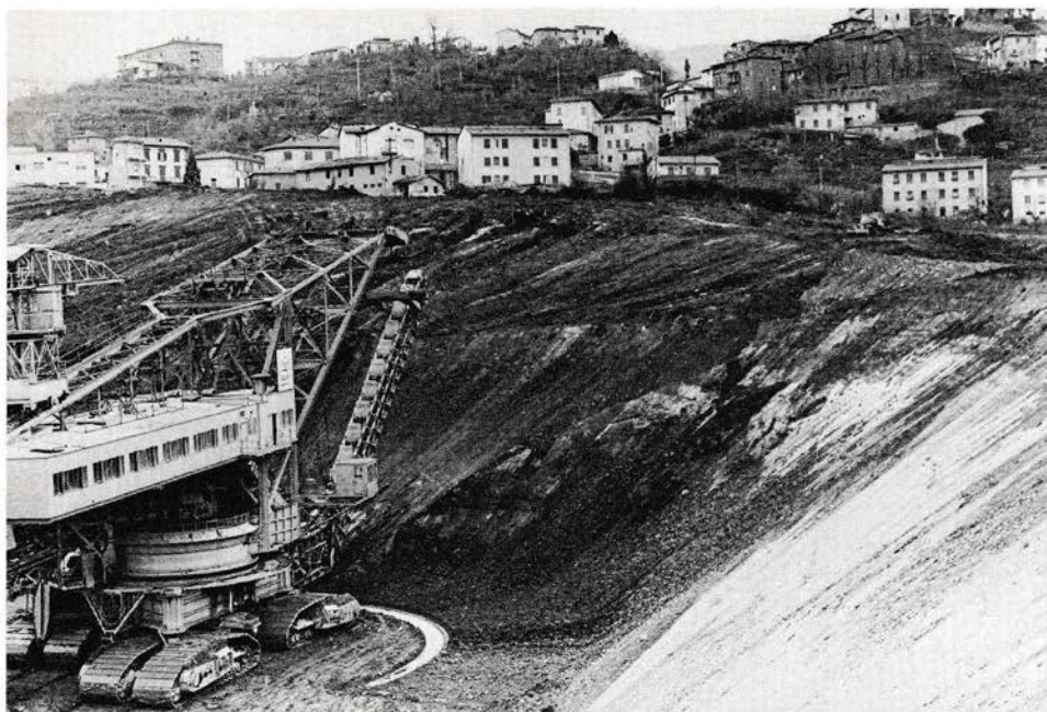
1957- L'escavazione a cielo aperto.
