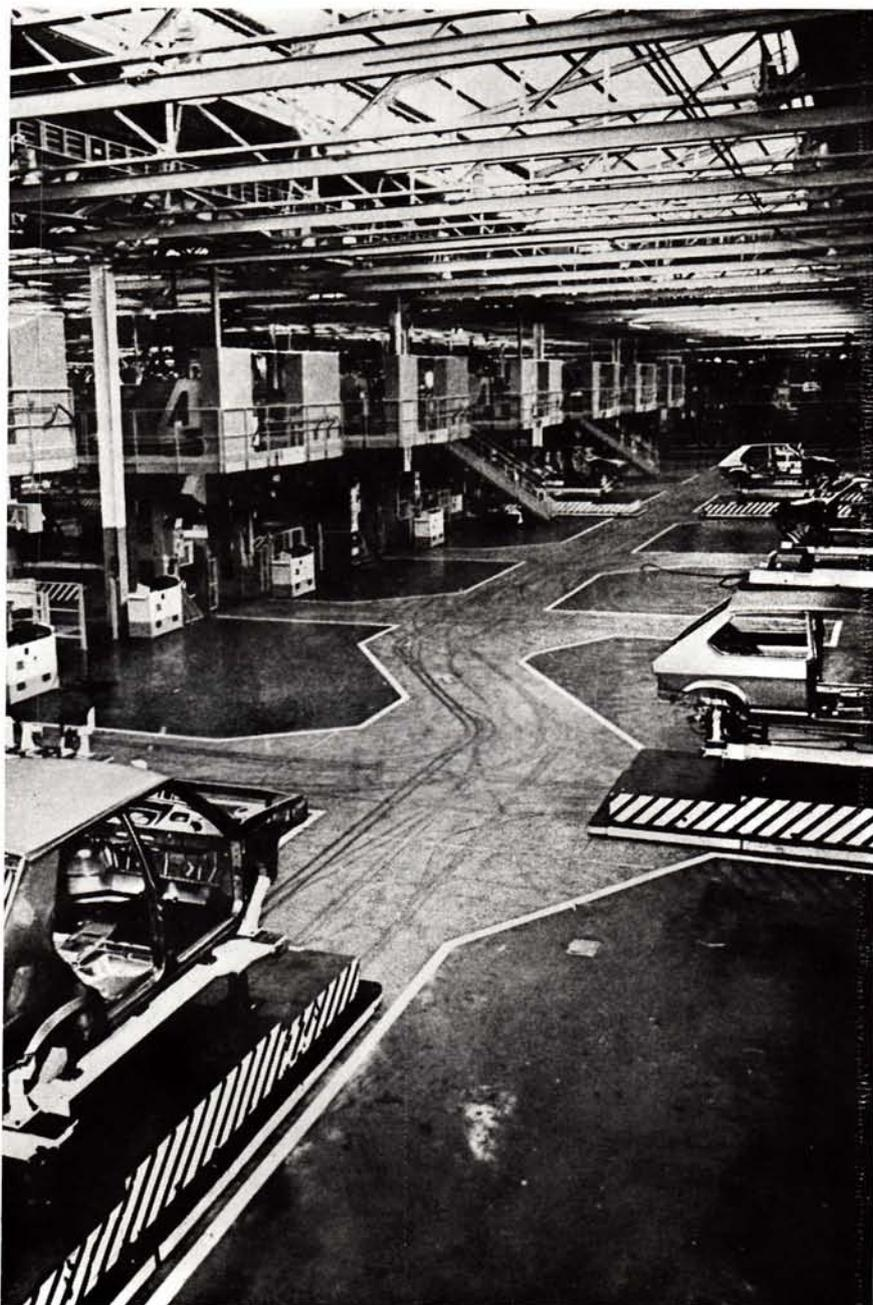
Scocche movimentate da Robotcarrier lungo le stazioni di saldatura del Sistema ROBOGATE
